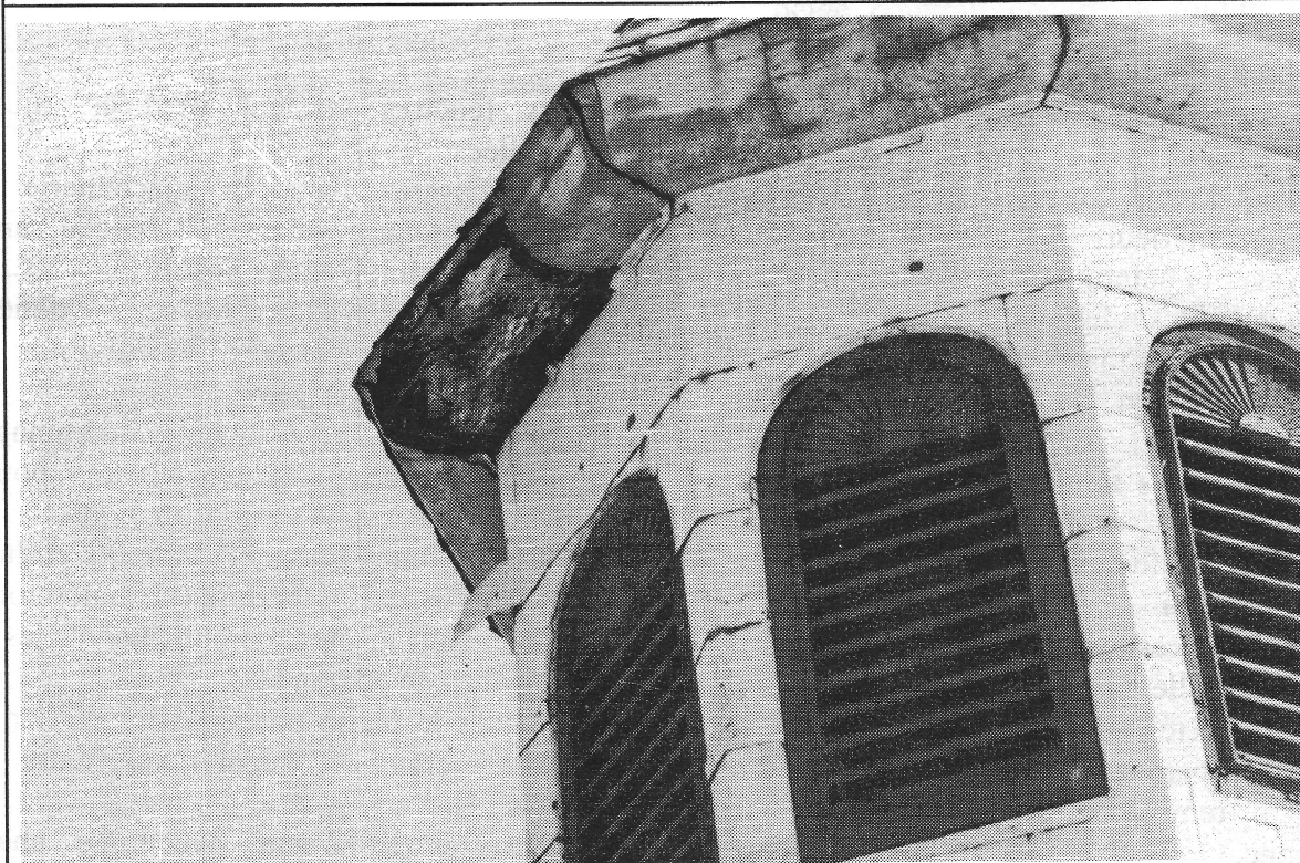
L'humidité a pénétré le clocheton
